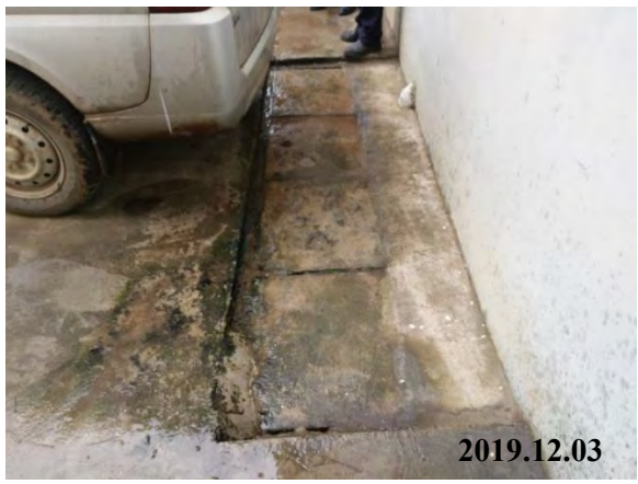
院内雨水收集沟渠
