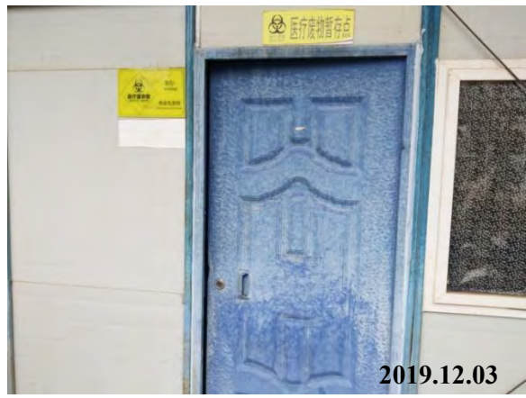
医疗废物暂存间
