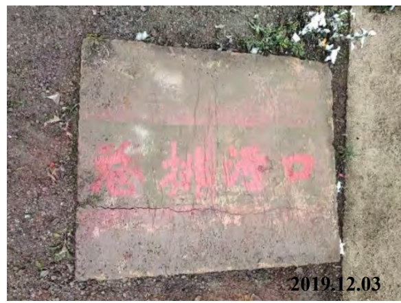
污水总排放口
